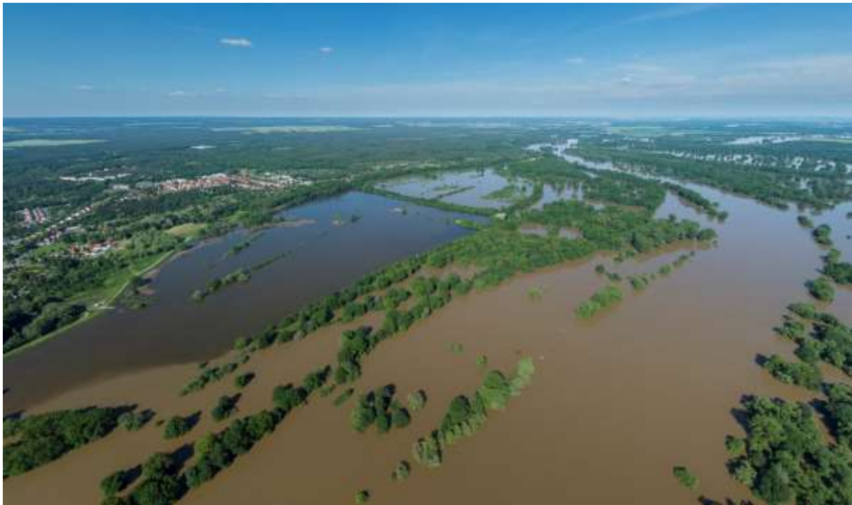
Abb. 1 Das Roßlauer Oberluch während des Sommerhochwassers am 06.06.2013 (Foto: A. Künzelmann).
